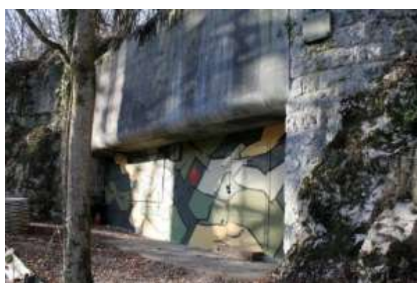
Eingang Bunker Nord A 3491
