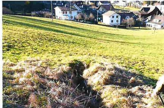
Abb.9: Der Einlauf in die Eindolung ist ungünstig, der "Rechen" verklaust schon bei kleinen Ereignissen, der Bach fliesst dann oberirdisch in der Geländemulde in Richtung Siedlung.
