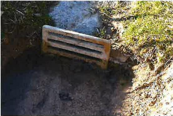
Abb.6: Der Einlauf in den Schacht vor der Kantonsstrassenquerung. Der "Rechen" verklaust schon bei häufig wiederkehrenden Ereignissen.
