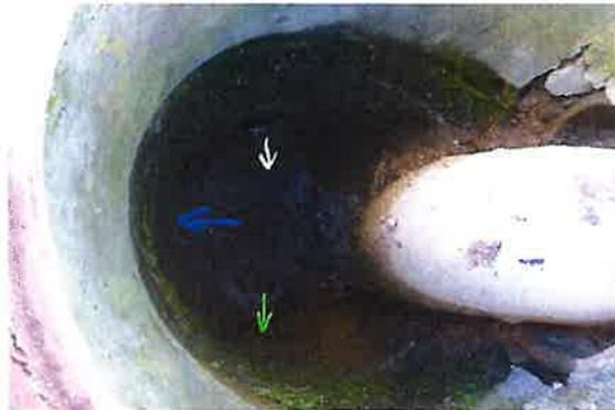
Abb.7: Der Schacht vor der Kantonsstrassenquerung. der Bach fliesst via den Tauchbogen in den Schacht und quert die Strasse in einem Rohr mit 30cm Durchmesser (blauer Pfeil). Eine Leitung längs zur Kantonsstrasse mündet in den Schacht (weisser Pfeil) und führt weiter in Richtung Ringbach (grüner Pfeil).
